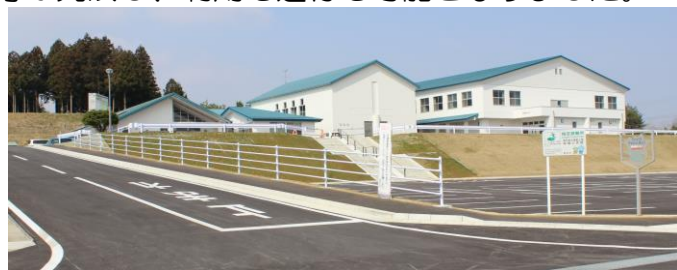
▲完成した公民館入口道路と駐車場〔右側〕
