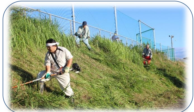
▲多目的グラウンド側法面の草刈り作業
